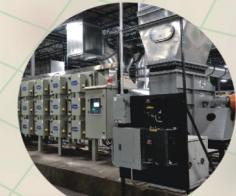
纺织定型机热回收油雾净化
