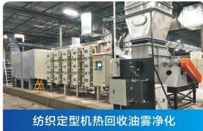
纺织定型机热回收油雾净化
